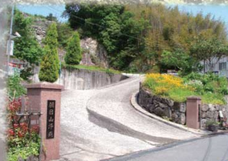
山の東面 浄苑入口風景
